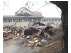
東北大学(建物の損壊)
