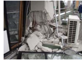
東北大学(柱の破壊)
