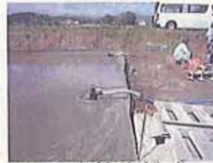
Cs汚染粘土排水
