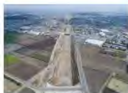
(平成30年3月完成)南橋市道橋工事
