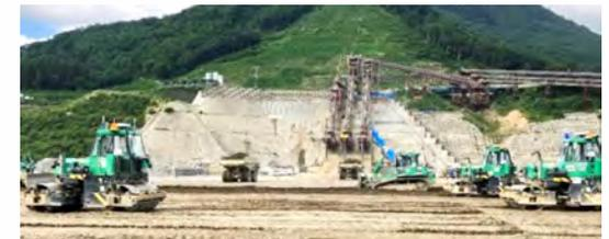
↑無人建機群による自動化施工システムの現場運用開始 鹿島建設
