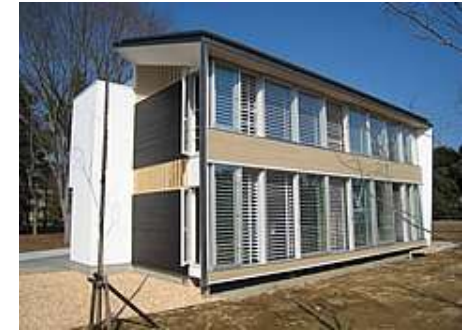
LCCM住宅デモンストレーション棟 (建築研究所内)
