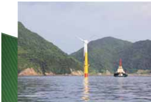
【長崎県 五島列島 浮体式洋上風力実証】
