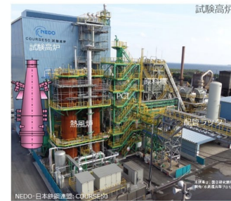
COURSE50試験高炉
