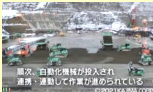
複数重機によるダム施工 (鹿島建設)
