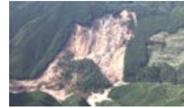
河道閉塞の 災害現場
