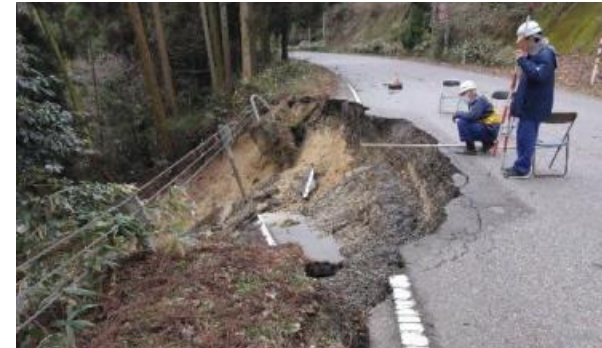
令和6年能登半島地震からの復旧作業の様子
