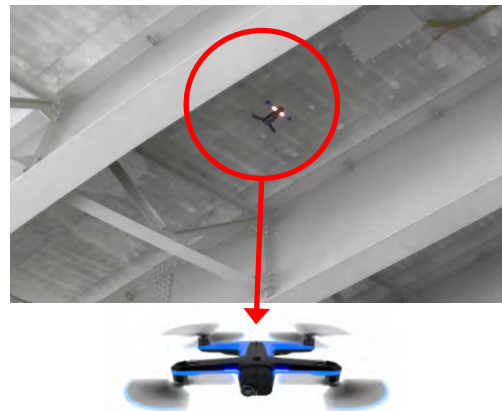
橋梁点検実証の様子
