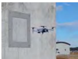
ドローンによる損傷把握
