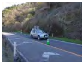
MMS※1を活用した 斜面・のり面点検
