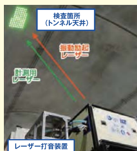
●トンネル内レーザー打音検査
