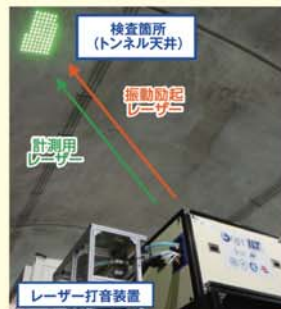
●トンネル内レーザー打音検査
