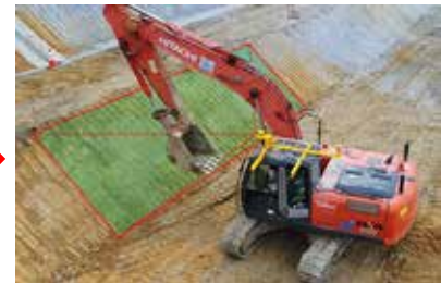
重機搭載LSによる測量
