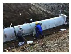
プレキャスト底樋の試験施工
