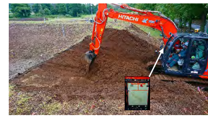
ICT建機による施工
