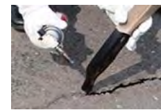
充填材による補修
