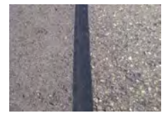
シール材による補修
