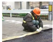
止水テープによる補修
