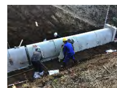
プレキャスト底樋の試験施工
