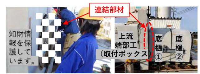
連結部材の試験（屈曲時の一体性の確認）
