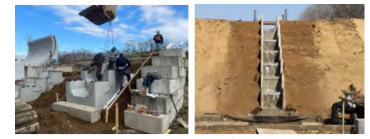
据付施工試験
