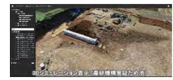
調査・測量会社の測量システム
