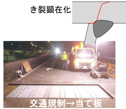
(例)一般国道357号市川大橋では、鋼床版の当て板補修で約1ヵ月半の夜間交通規制
