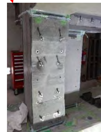
1F柱のUFCパネル補強
