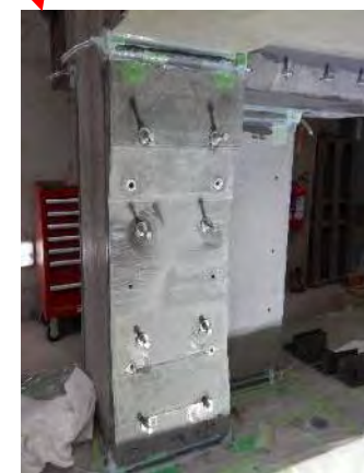
1F柱のUFCパネル補強
