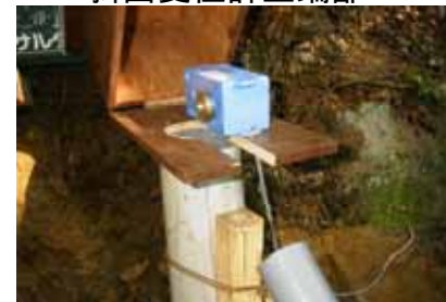
斜面変位計上端部
