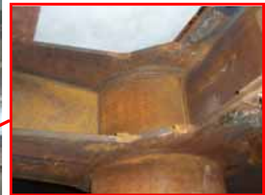
柱・はり・リングソケットの状況 (無損傷)
