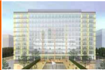
都心周辺部に建つ、高耐震中高層オフィスビル
