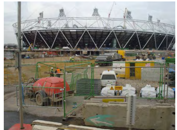
オリンピック会場工事現場
