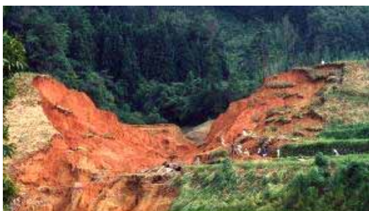
豪雨によって決壊したため池
