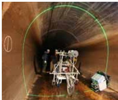
レーザーによる壁面画像撮影技術
