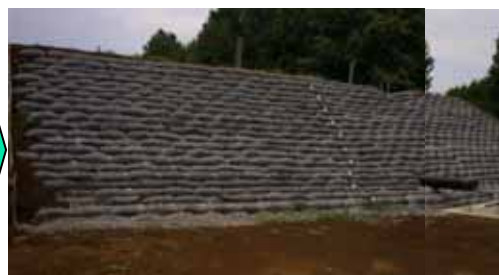
テール土嚢を用いたため池の高耐久性化
