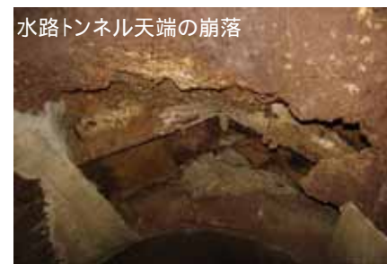
水路トンネル天端の崩落
