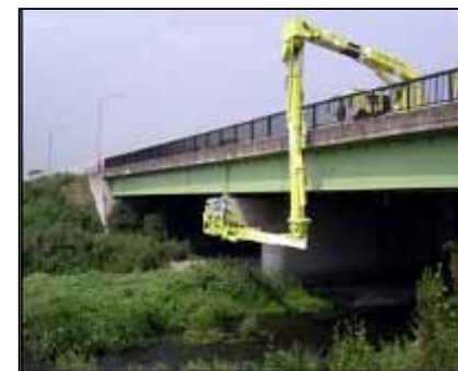
橋梁点検足場用の機械 (橋梁)
