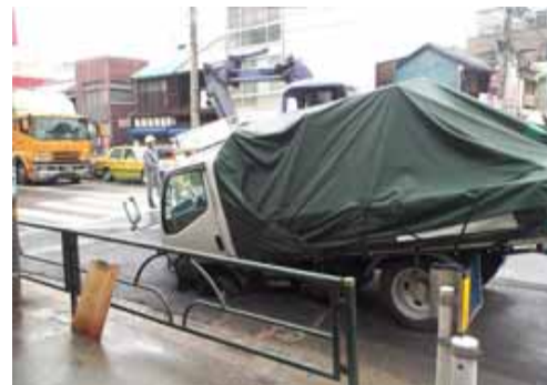
管路施設が原因となった陥没事故
