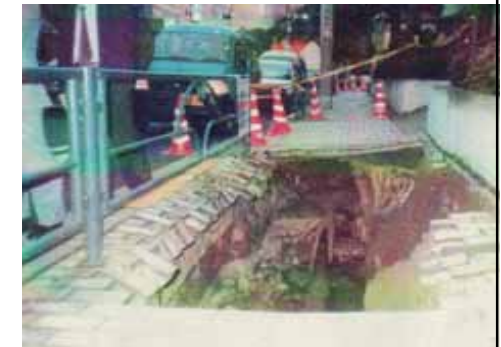
管路施設が原因となった陥没事故
