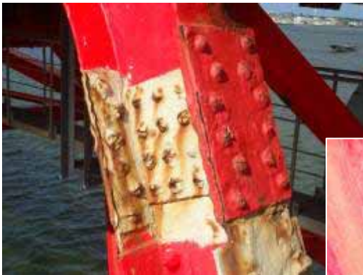
欠損補強部の再劣化
