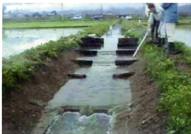
写真 3.3.2 排水路をセキ上げした簡易魚道（琵琶湖畔の試験池）
