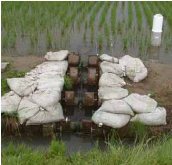
水田魚道排水柵
