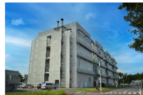
シリコンデバイスの試作設備 量子アニーリングコンピュータの部素材の試作等が可能
