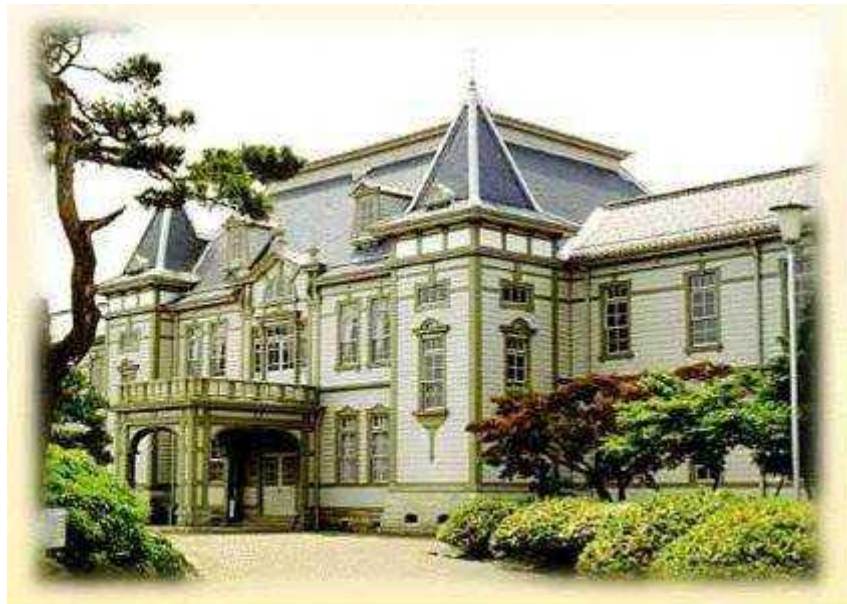
旧米沢高等工業学校本館（国の重要文化財）
