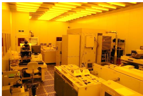
微細パターンの転写を行う イエロールーム
