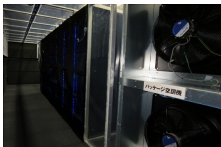
サーバーと空調機器
