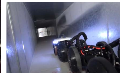
ダクト内移動の実証実験
