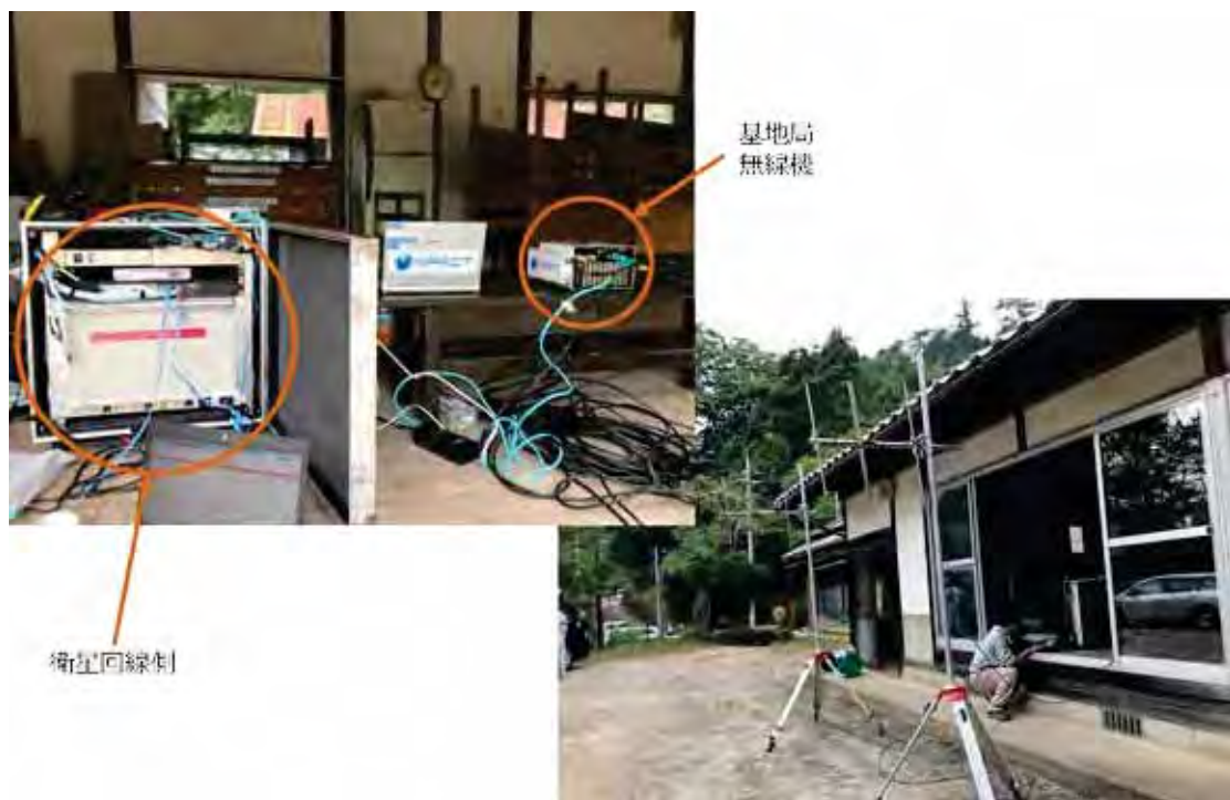
図 14 西日本豪雨支援（基地局：無線機、アンテナ設置の様子）
