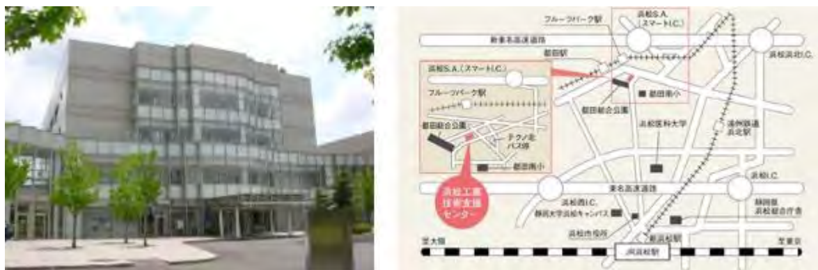
図 2-3-12 浜松工業技術支援センターの外観と交通アクセス
