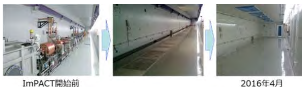
図 2-1-21 プラットホーム・レーザー室の整備の様子（組立調整実験棟@理研播磨）
