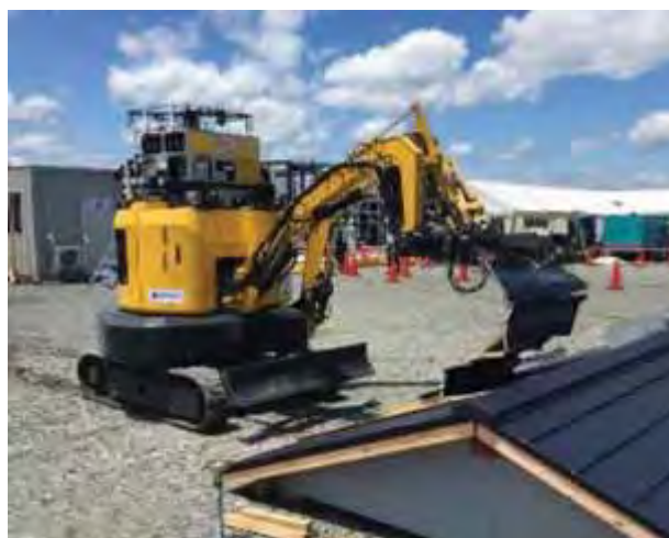
図2-6-27 力覚提示を使った屋根板剥がし作業
