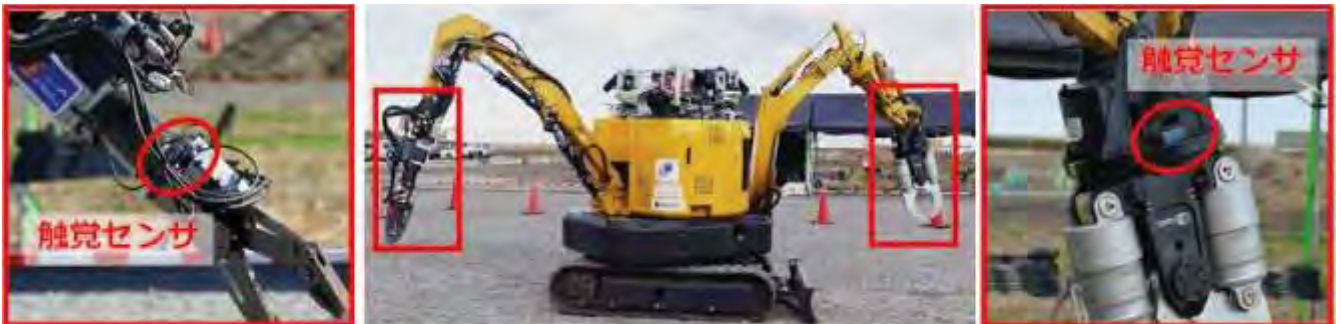
図2-6-28 双腕建設ロボットに搭載した触覚センシングシステム
