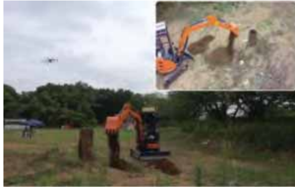
図2-6-10 無人建設機械に搭載した有線給電ドローンの試験の様子
