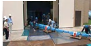
高圧ケーブル搬入 (2011.9月)
