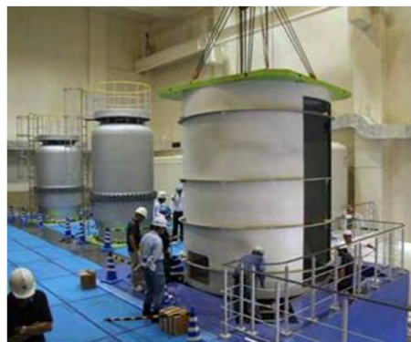
電子銃 制御信号 発生タンク
