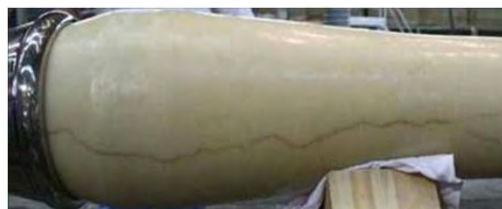
高圧ケーブル放電痕
