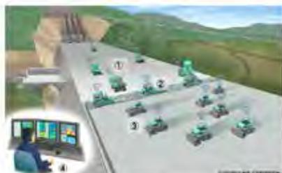
CSGダム建設工事最盛期のA4CSEL適用イメージ
