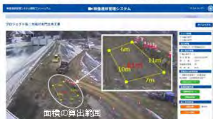
資材ヤードの面積計測
