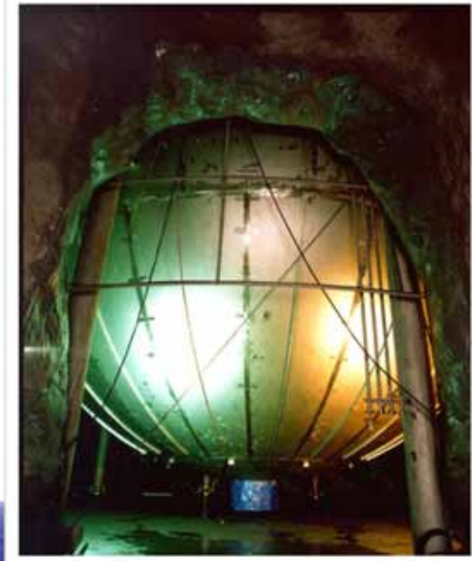
建設中のカムランド測定器外観(2000年頃)
