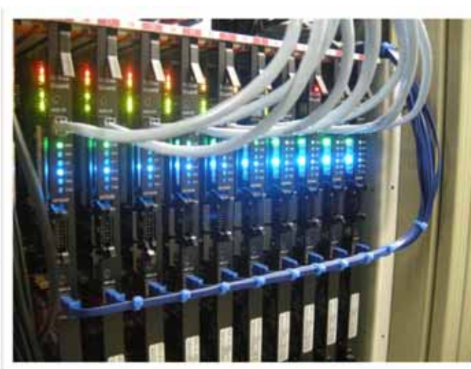
スーパーカミオカンデ用に企業と協力して開発されたエレクトロニクスシステム
