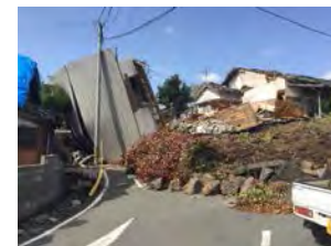
熊本地震で倒壊した建物
