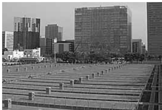
東京都下水道局 芝浦水再生センター
