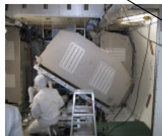
きぼう船内実験室へのラック艀装
