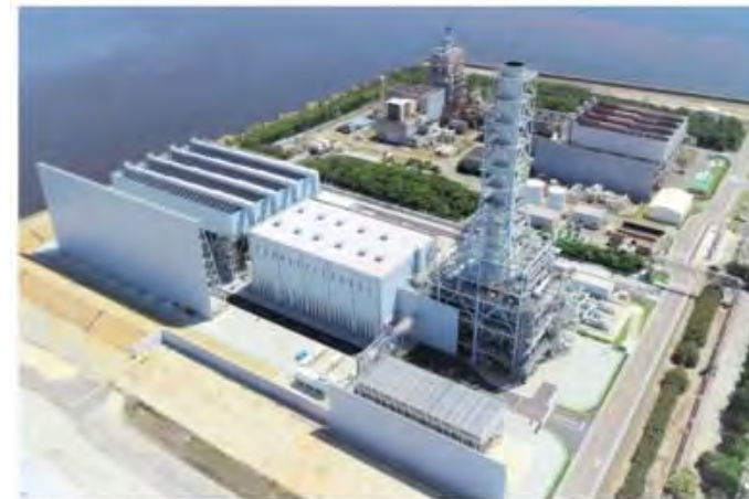
新たに長期実証運転を開始した第二地点(写真手前)
