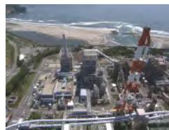
石炭をガス化し、ガスタービンと蒸気タービンによるコンバインドサイクル方式を利用した石炭火力。
