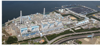
碧南火力発電所（愛知県碧南市） 出典：IHI プレスリリース
