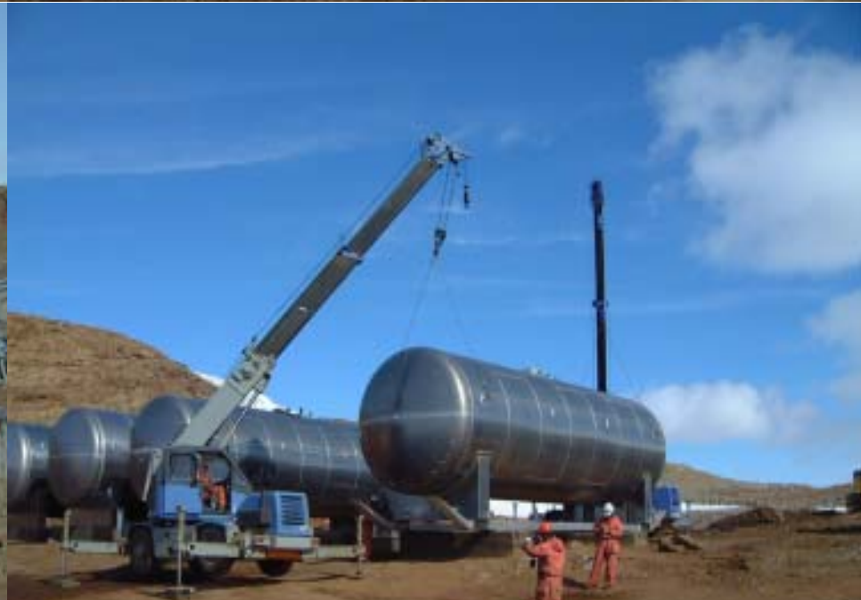
燃料タンク 基礎工事
