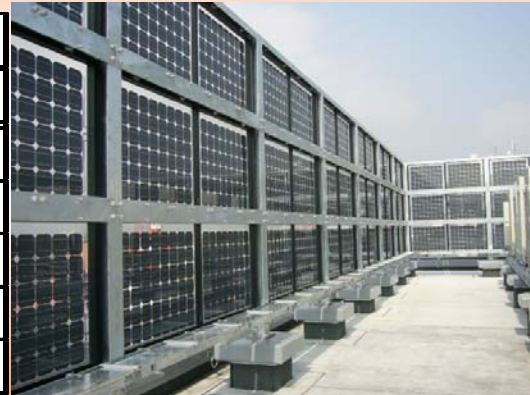
京都府ビル屋上(10kW) 両面受光型太陽電池
