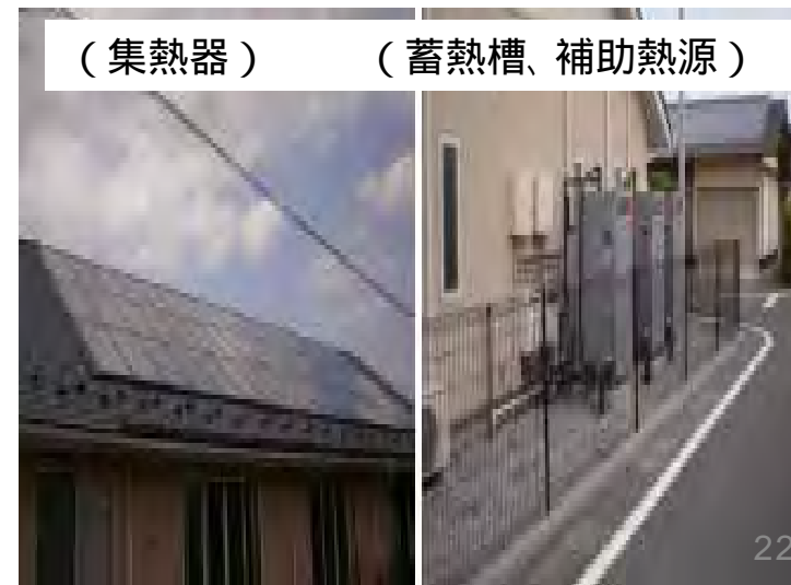
図3 老人ホームへの設置例(長野県)
